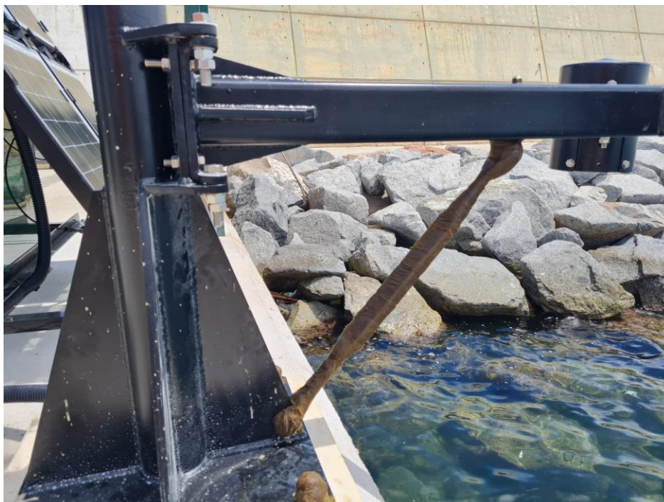
Figura 53 Cinta Denzo aplicada al tensor y pernos.
