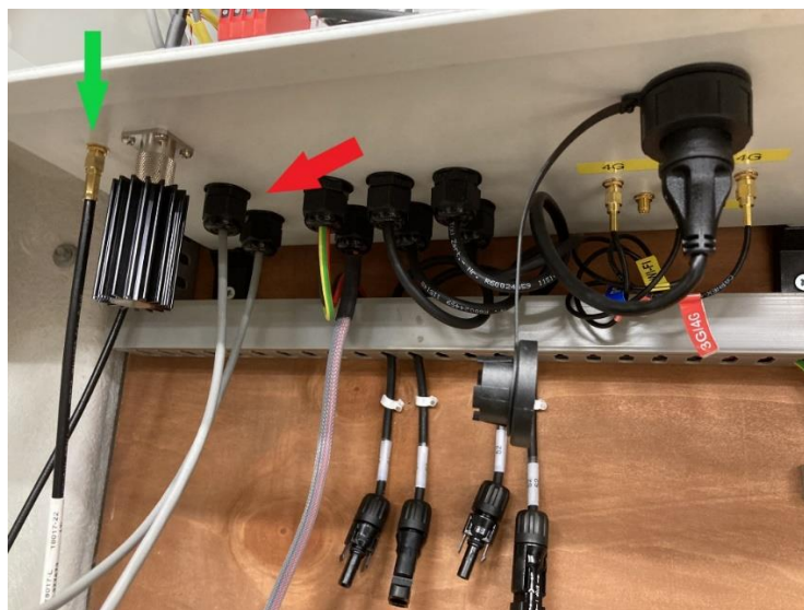
Figura 36 Conector de antena Meteosat Yagi y cables de radar.
