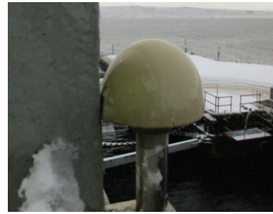
Figura 7. Agrietamiento de la carcasa exterior de una antena GPS
