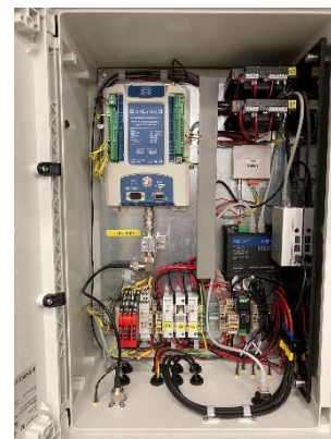
Figura 43 Recinto del registrador.
