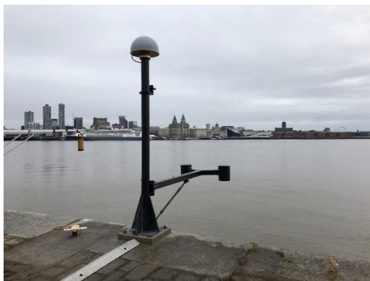
Figura 55 Instalación terminada con base de lechada.
