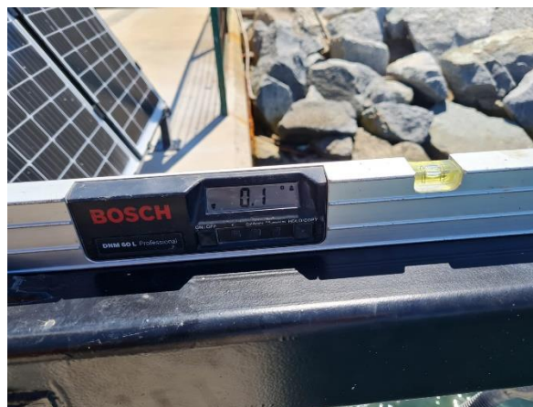
Figura 18 Nivelación del brazo del radar.
