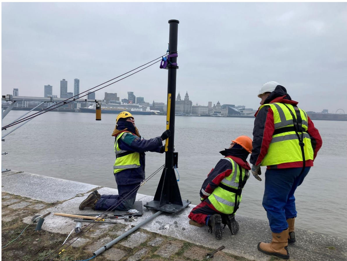
Figura 11 Nivelación del mástil GNSS.
