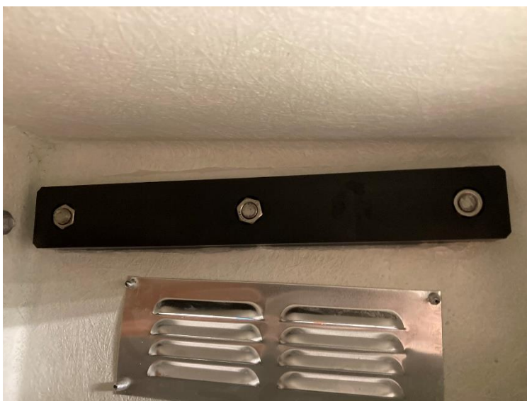
Figura 14 Pieza de soporte del marco del panel solar.
