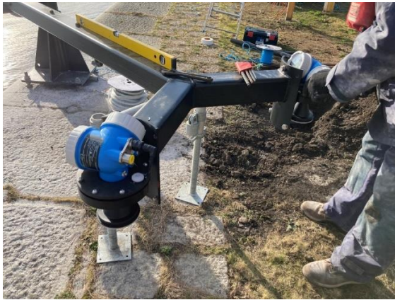
Figura 23 Instalación de los sensores de radar.
