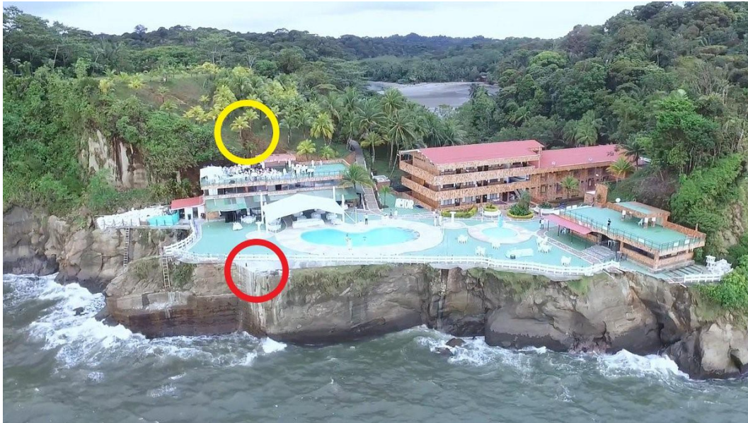
Figura 3 Ubicación del mástil GNSS y el gabinete de equipos en el Hotel Maguipi.
