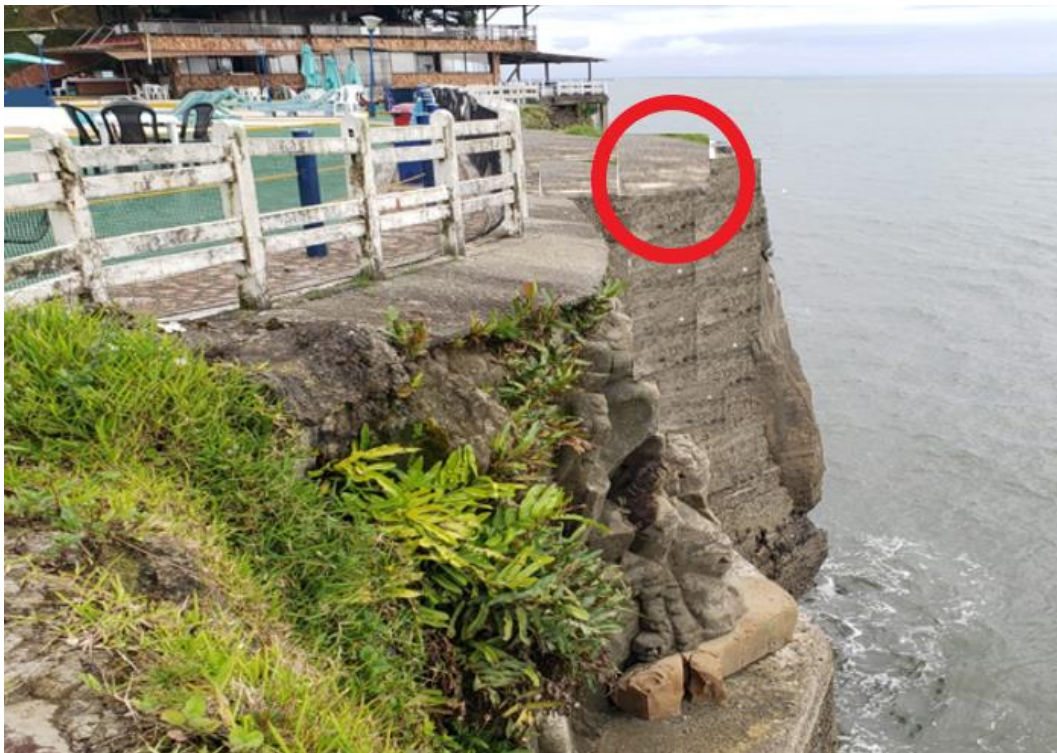
Figura 4 Sitio de instalación del mástil GNSS rodeado en rojo.
